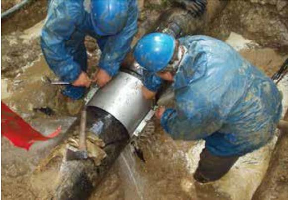
AVK可以提供多种快速维修夹和快速接头，方便用户在发现泄漏点时候快速进行维修。
